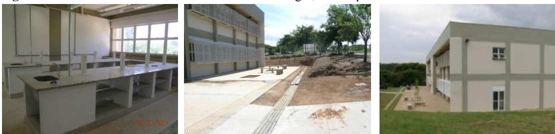
Figura 26 - Edifício de Gestão Ambiental - Biotecnologia, no campus São Carlos
