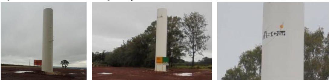
Figura 33 - Reservatório, no campus Lagoa do Sino
