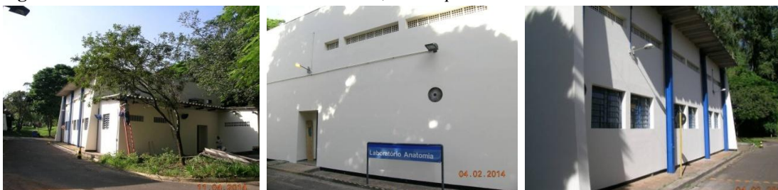
Figura 28 - Reforma do Laboratório de Anatomia, no campus São Carlos
