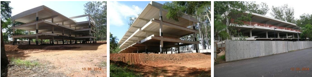
Figura 30 - Fundações e estrutura do Edifício 164 - Área Sul, no campus São Carlos
