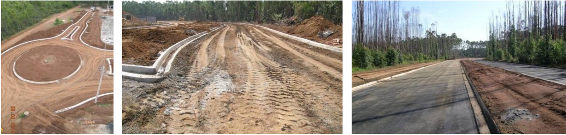
Figura 29 - Infraestrutura viária da área de expansão norte, no campus São Carlos
