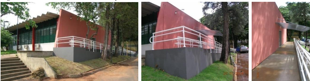
Figura 32 - Reforma Proex, no campus São Carlos
