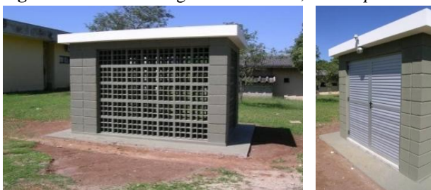
Figura 27 - Cabine do gerador da rádio, no campus São Carlos
