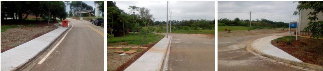
Figura 61 - Pavimentação de calçadas
