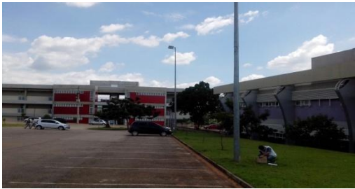
Figura 66 - Reforma da iluminação do Estacionamento do Prédio ATLab
