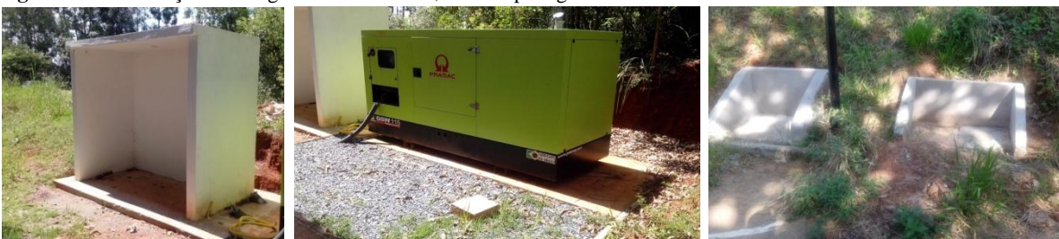
Figura 63 - Construção de abrigo de combustíveis, de base para gerador 110kva e de muros de arrimo no NECT
