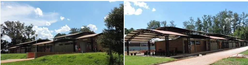
Figura 76 - Reforma de Galpão para Salas de Aulas
