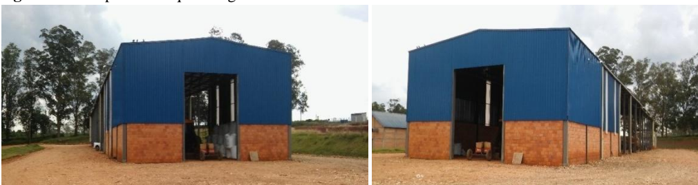
Figura 77 - Galpão de máquinas agrícolas
