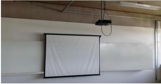
Figura 65 - Instalação de diversos suportes de data show, lousas e telas de projeção
