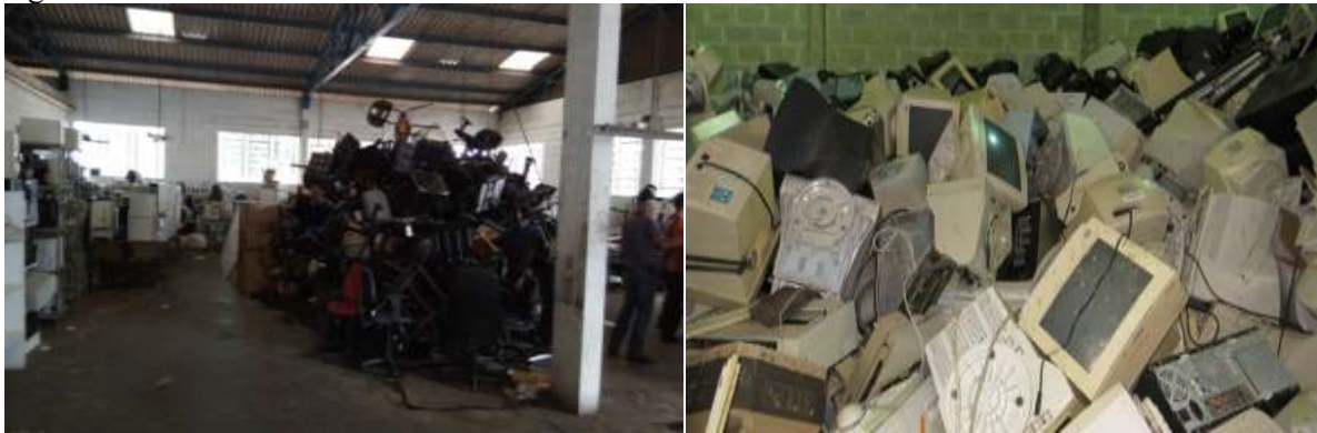
Figura 11.1 - Armazém antes da reforma
